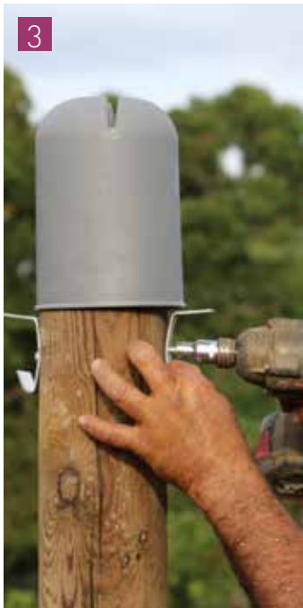
3 Pose des chapeaux et des crochets supportant les câbles.
