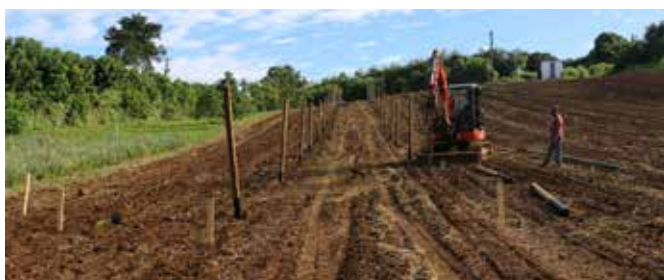
Mise en place des rangées de poteaux.
