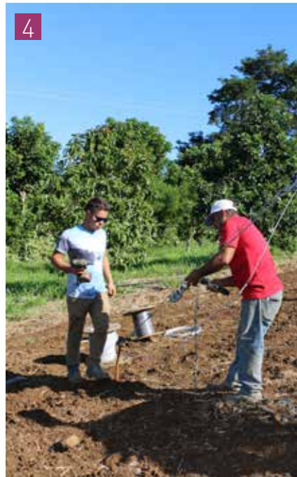
4 Installation, au sommet des poteaux, des câbles de fixation amarrés aux ancres.
