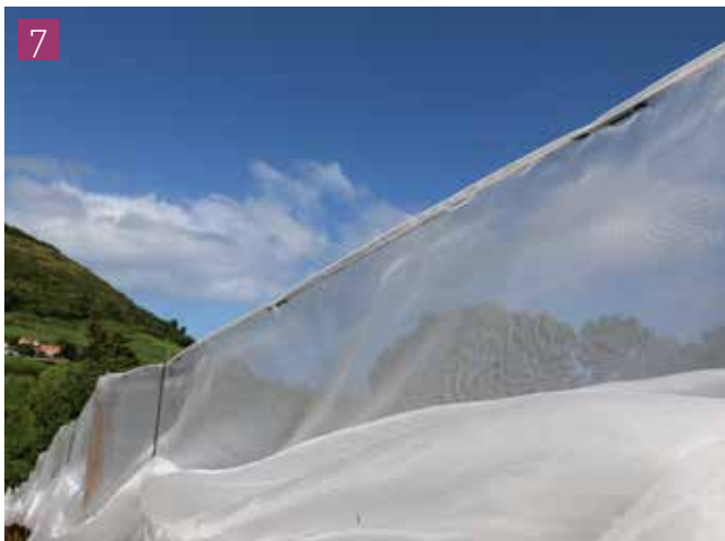
7 Fixation des filets sur les câbles, grâce à un système d'aiguilles.
