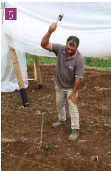
5 Installation des câbles à terre, maintenus par des piquets.
